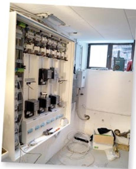
In unseren Objekten Goldammerweg 12/14 und Goldammerweg 16/18 mussten die Stromleitungen der Stadtwerke Fellbach in den Gebäuden erneuert werden. In diesem Zusammenhang wurden die Zählerschränke im Untergeschoss verlegt und neu installiert, so, dass es den neuesten, gesetzlichen Richtlinien entspricht.
