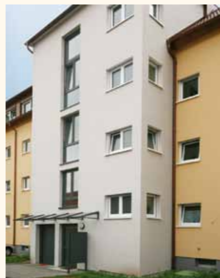
Eingangsbereich Im Vogelsang mit neuem Aufzug
