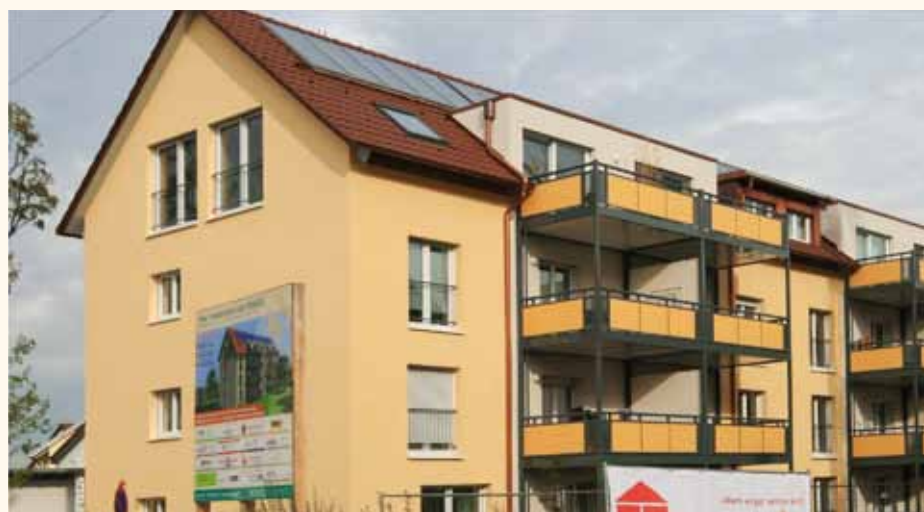
Saniertes Objekt Vogelsang 2/4
