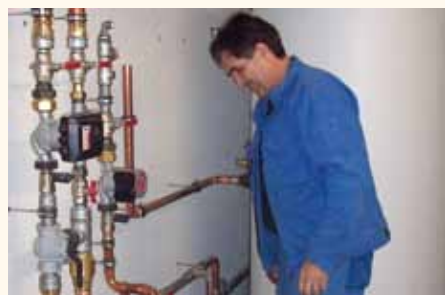
Heizung Eberhardstr. 77/79/81 u. 83/85/87
