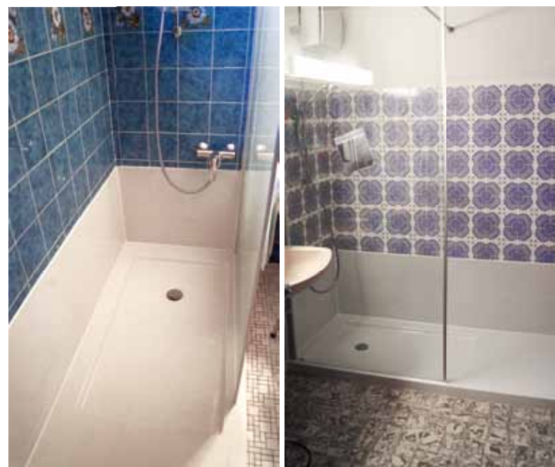
Umbau Wanne zur Dusche ohne Badmodernisierung im bewohnten Zustand.
