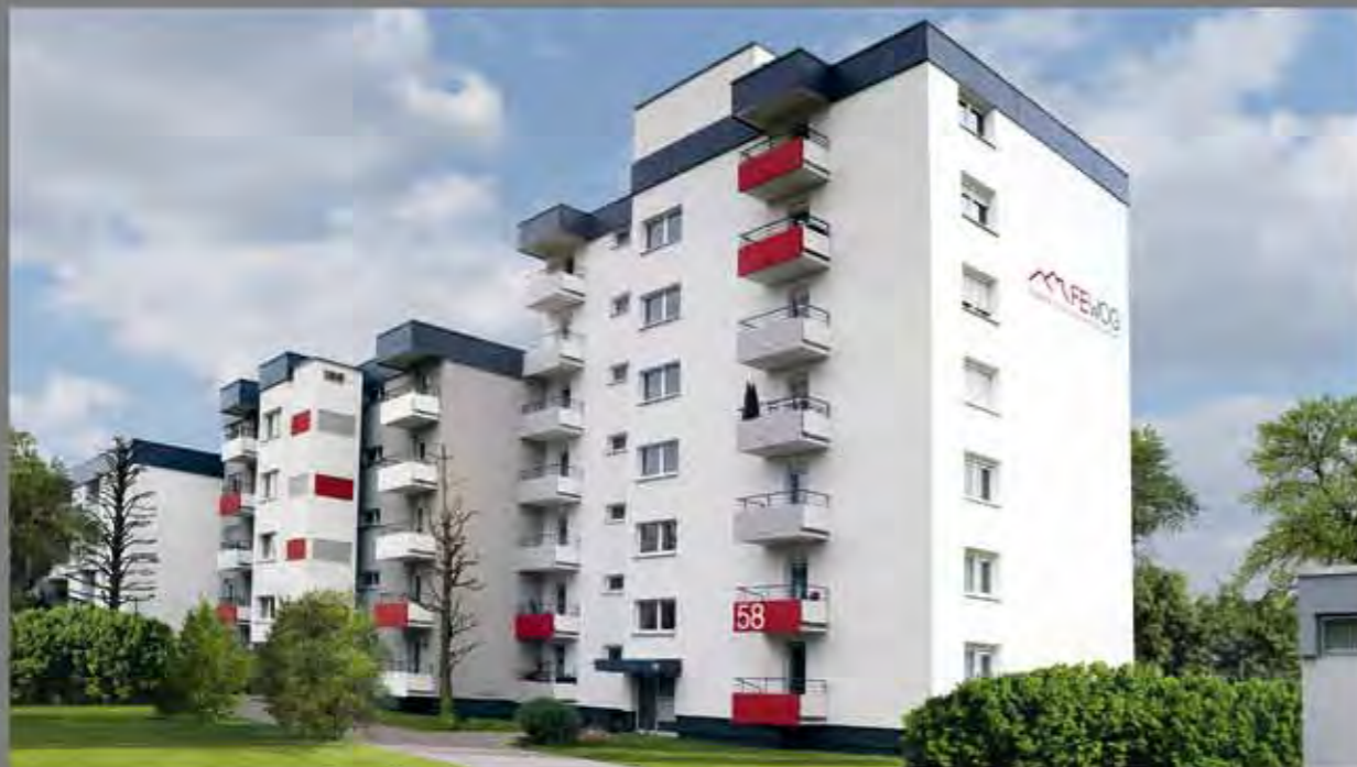
Energetische Sanierung der Waiblinger Str. 58 – 64 Anbringung eines Wärmedämmverbundsystems mit Anstrich und Logo in den FEWOG-Farben
