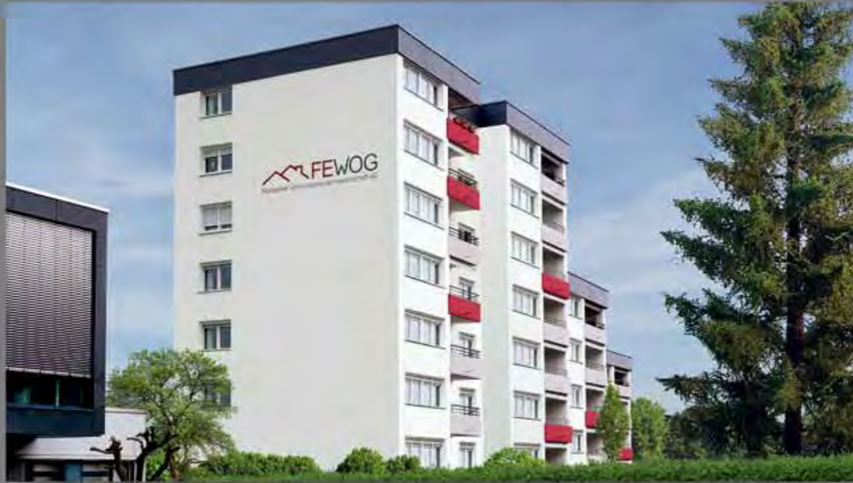
Energetische Sanierung der Waiblinger Str. 58 – 64 Anbringung eines Wärmedämmverbundsystems mit Anstrich und Logo in den FEWOG-Farben
