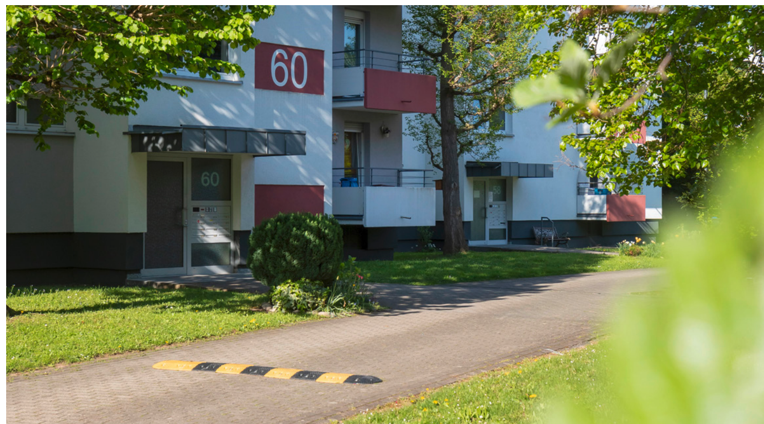
Für ein Plus an Sicherheit und Lärmreduktion: Einbau von Bodenschwellen in der Waiblinger Straße 58 bis 64.
