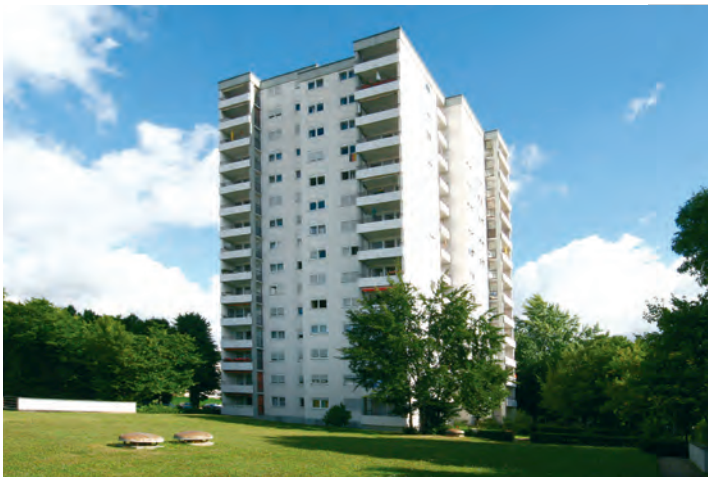
Hochhaus Waiblinger Straße
